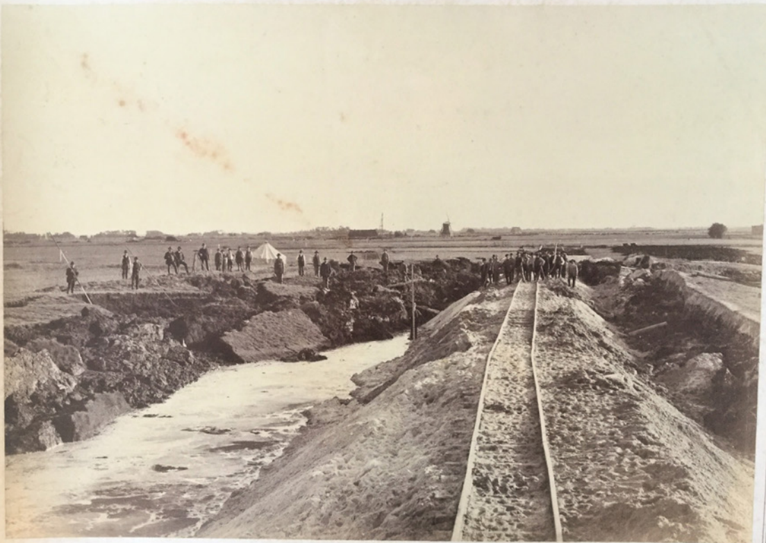
Bau des Nord Ostsee Kanals
