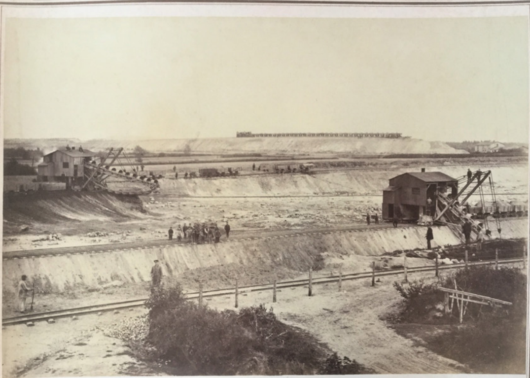
Bau des Nord Ostsee Kanals
