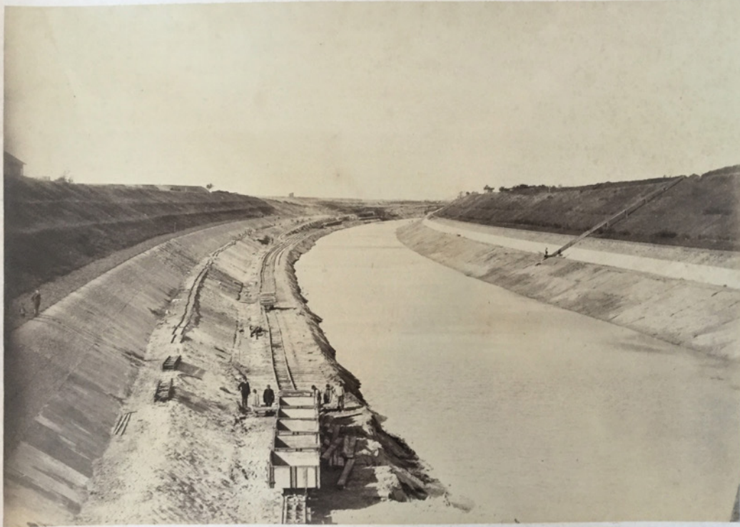
Bau des Nord Ostsee Kanals
