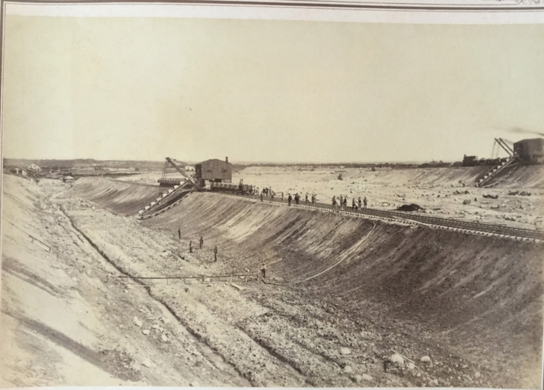
Bau des Nord Ostsee Kanals
