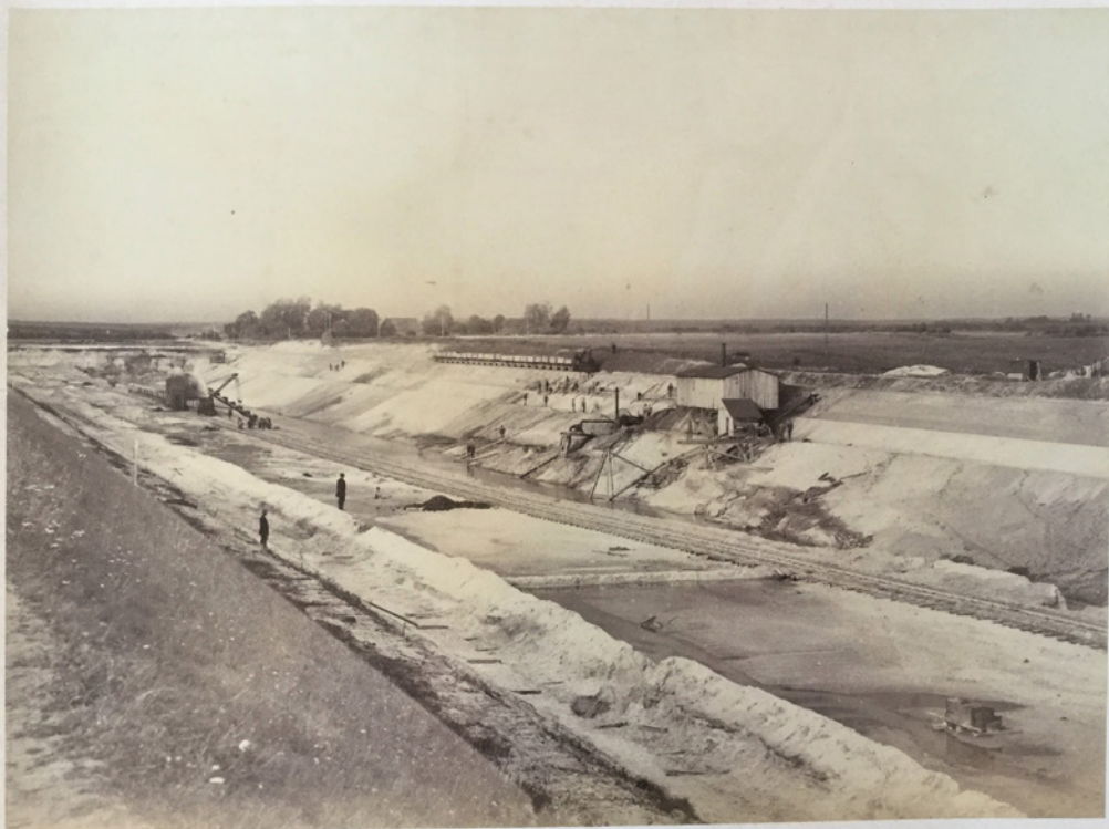
Bau des Nord Ostsee Kanals
