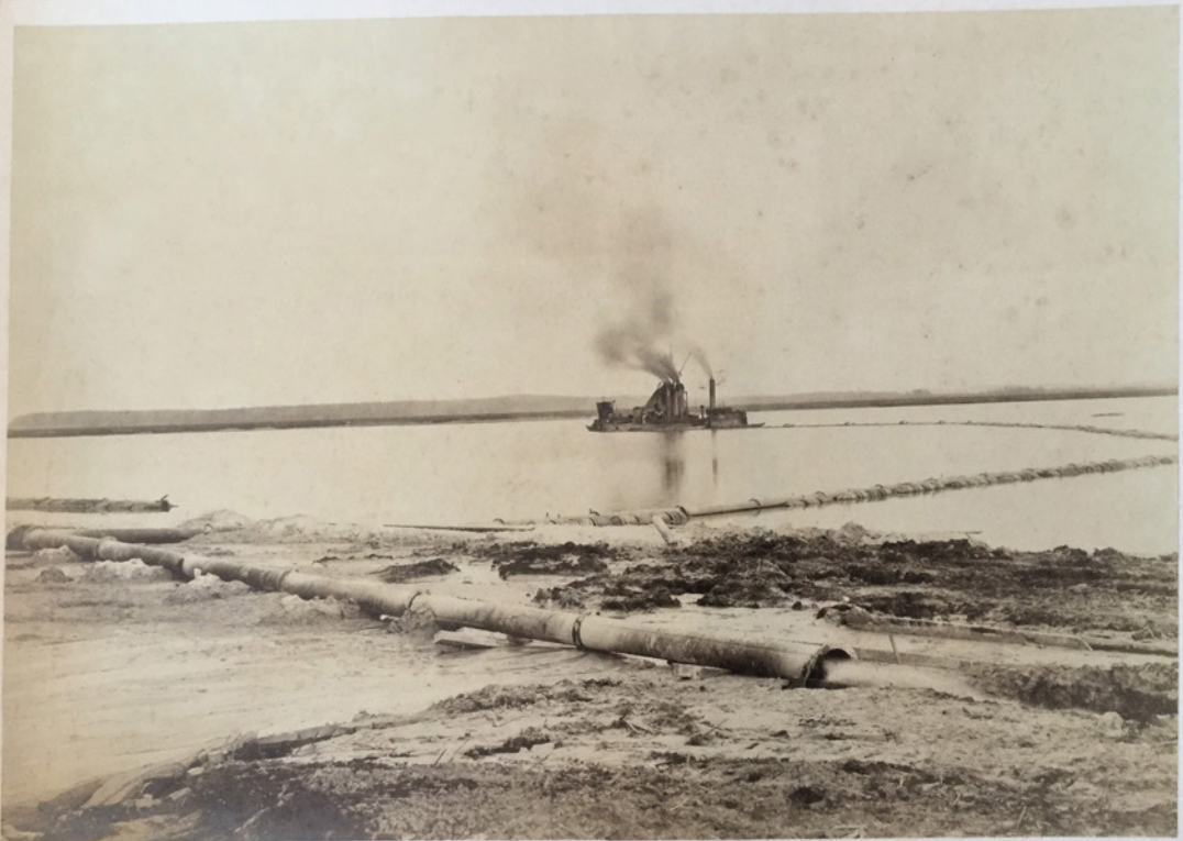
Bau des Nord Ostsee Kanals
