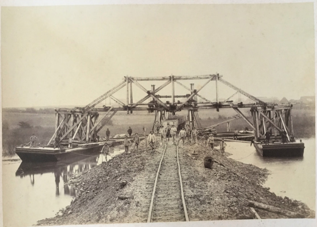
Bau des Nord-Ostsee-Kanals
